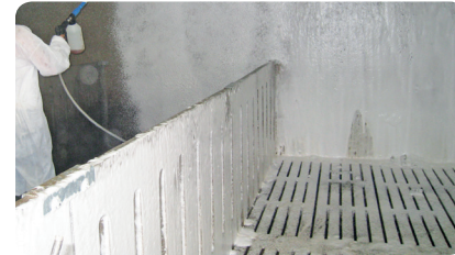
PASO 2 Aplicar el producto con la lanza de espuma que se encuentra unida a la máquina de alta presión (50-150 bar).
