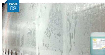
Limpieza Aplicar espuma/spray con alta presión. Dilution: 1 - 2%.
