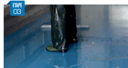
ETAPE 03 Rincer à l'eau Rincer à l'eau avec un nettoyeur à haute pression (50-150 bar et 12-30 L par minute) et laisser sécher.
