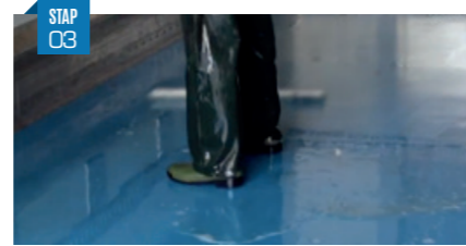
Spoel met water Spoel met water (hogedruk reiniging (50 – 150 bar en 12 – 30 Ls/min) en laat drogen.
